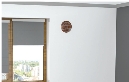
DO OTVORU NA MONTÁŽNÍ PĚNU NEBO JINÉ TĚSNĚNÍ VMONTUJEME REKUPERÁTOR
